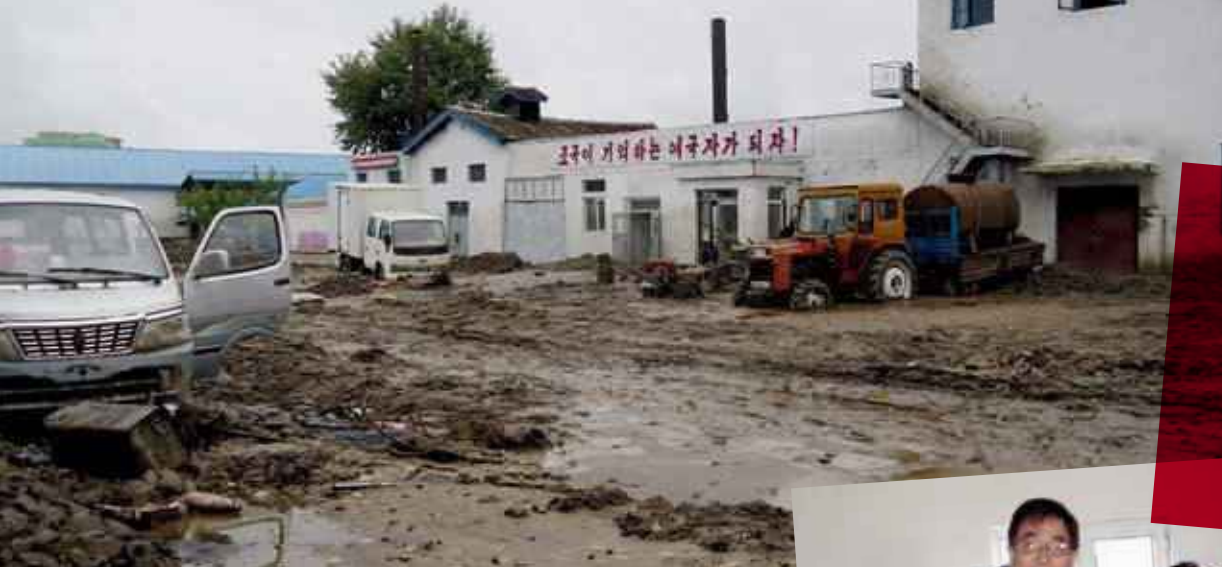
Durch die Fluten zerstört Bäckereien im Katastrophengebiet
